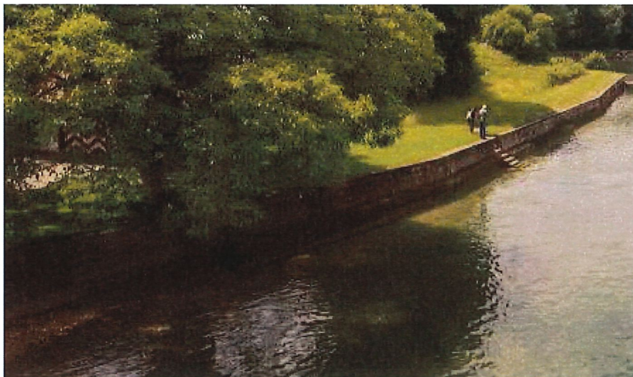
Heutige Situation: Betonmauer im Bereich Schupfen mit Wanderweg
