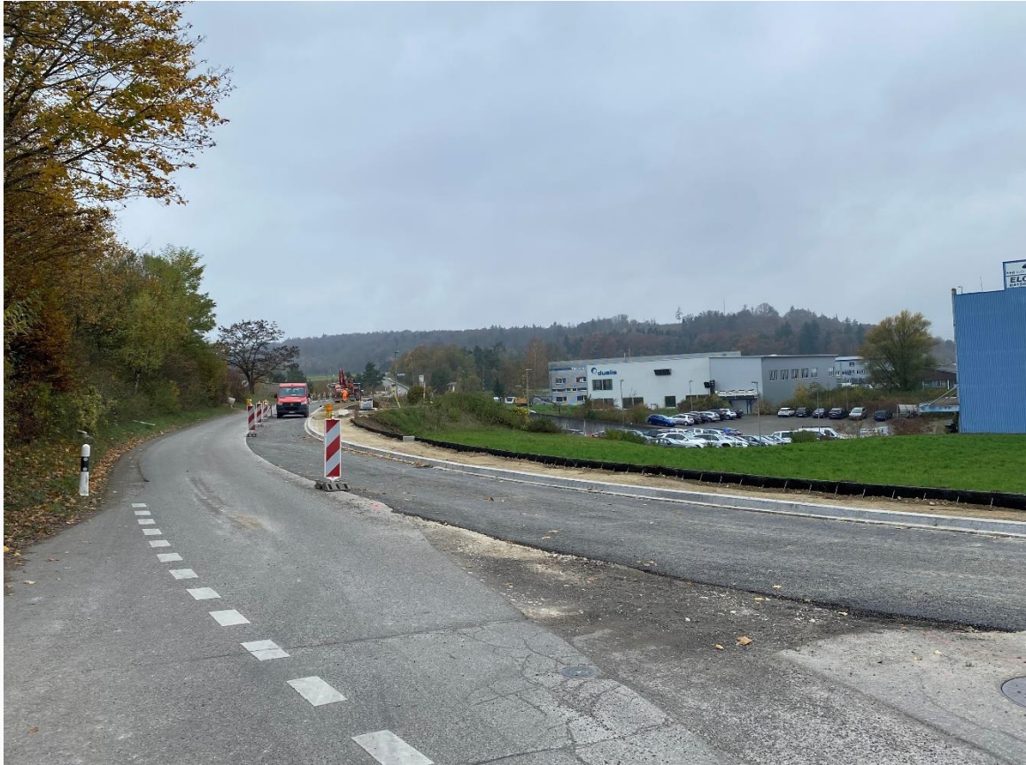
Die Sanierung der Buechbergstrasse schreitet voran
