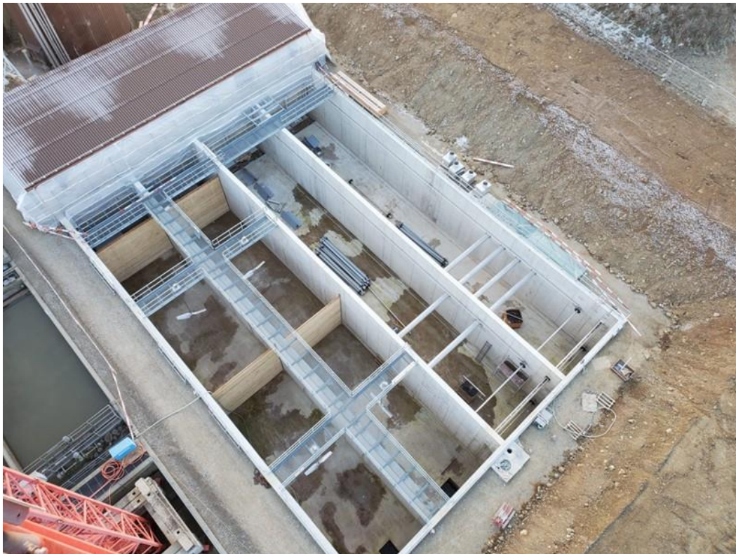
Die Kläranlage während den Ausbauarbeiten
